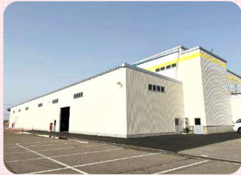
第2工場ヤード下の新設倉庫
